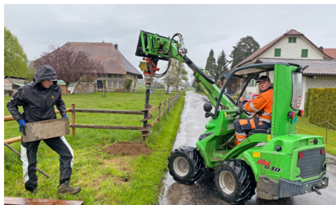
Buurelandweg: Fleissige Helfer bauen den Erlebnisweg auf.
