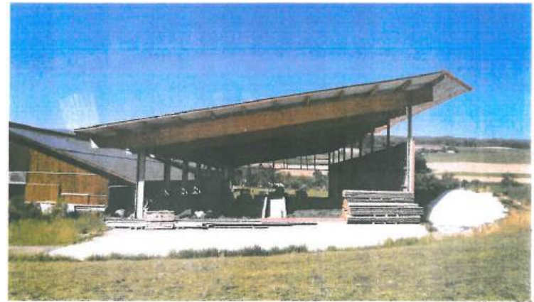
Dach Fahrsilo verlängern
