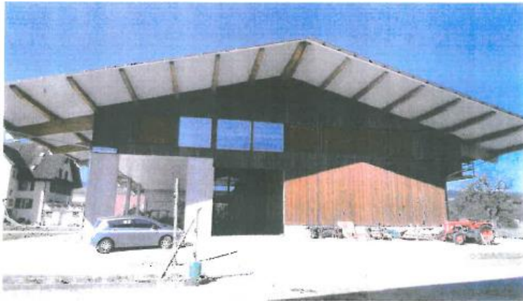
Neue Lichtplatten einbauen
