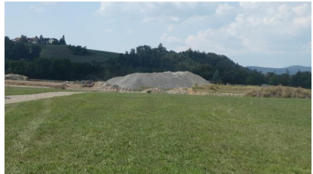
Erweiterungsfläche mit ehemaligem Kiesabbaugebiet
